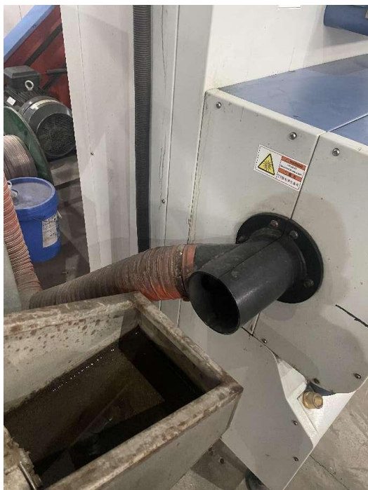
挤出机管道直连收集设施
